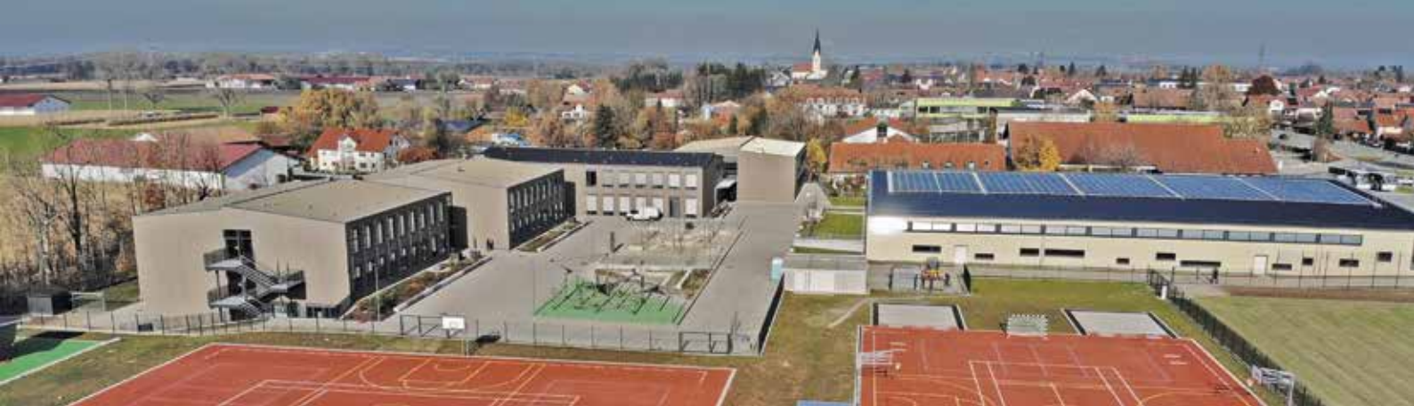
Der Schulhausneubau Oberding 2022
